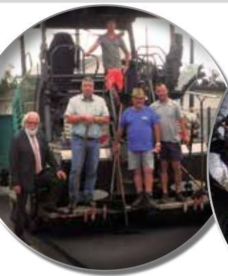
NEUGASSE SANIERT entlang des Friedhofs, ca. 1.250 m 2 Straße saniert
