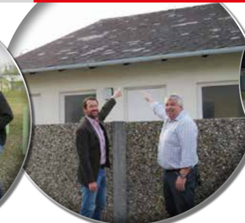
NEUES DACH FÜR DIE AUFBAHRUNGSHALLE bis Sommer 2019
